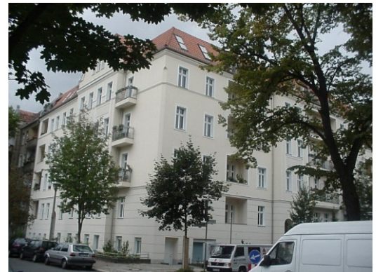
Solonplatz 3 - Meyerbeerstr. 95 in Berlin - Weissensee
